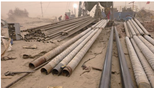
图3 滤水管包网照片
