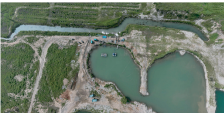
图 1 抽水试验场地
