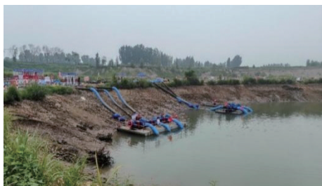
图3 浮船明排施工现场
