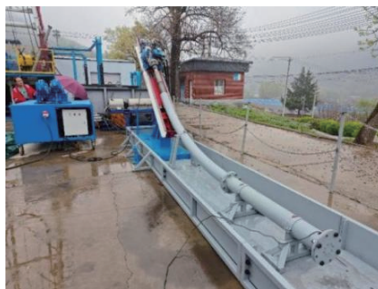
图8 钻进试验现场工况
