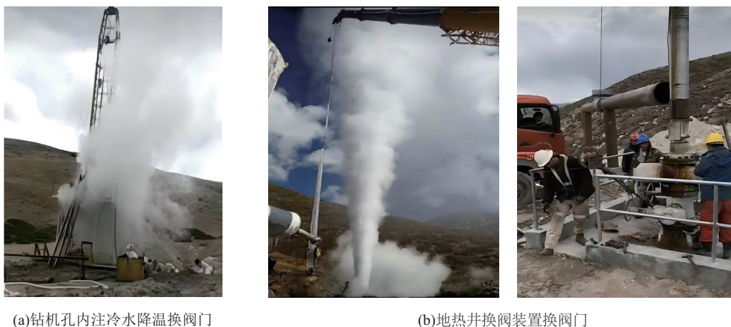
图8 现场换阀门场景
