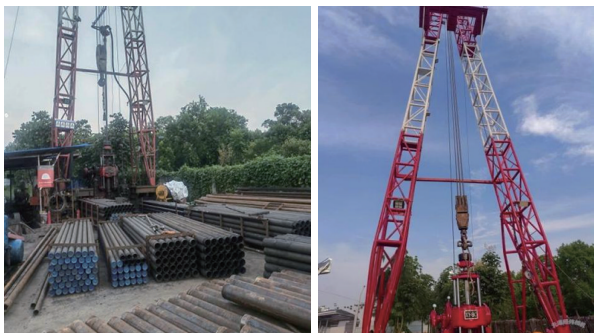
图 1 厚松散层钻进施工现场
