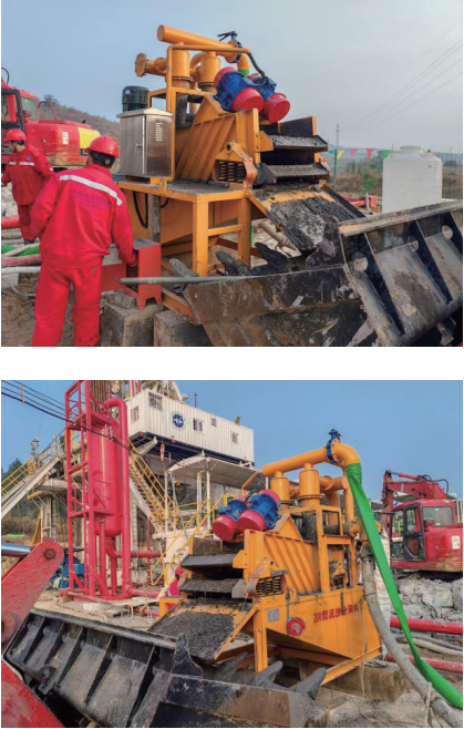
图 6 现场泥砂分离器进行废浆泥砂分离
