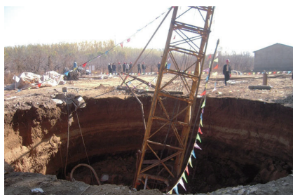
图1 顺义钻孔塌陷事故
