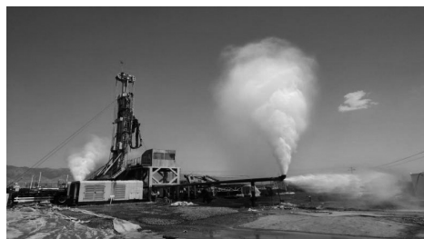
图6 井口封闭后双方向引流
