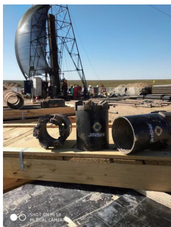
图8 砂岩型铀矿施工现场
