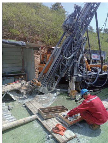
图10 大乌苏南沟矿区铁矿施工现场
