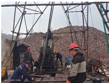
图9 河北迁安北屯北铁矿施工现场
