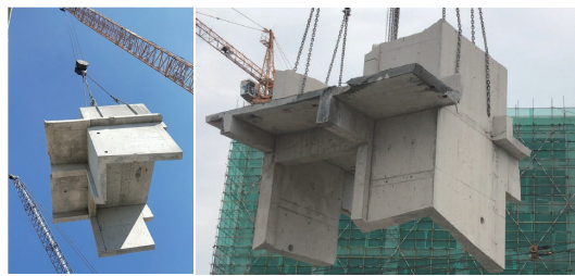
图7 起重圆环链条吊装
