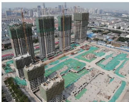
图6 高层建筑搭设悬挑临边防护效果
