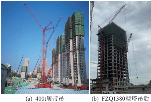
图 5 吊装设备安设
