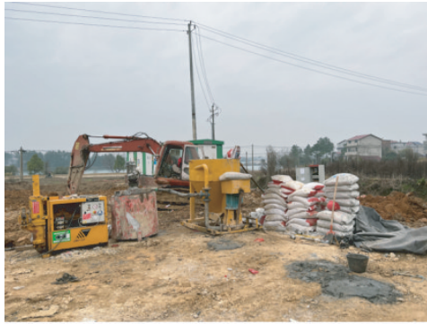
(a) 注浆实验现场
