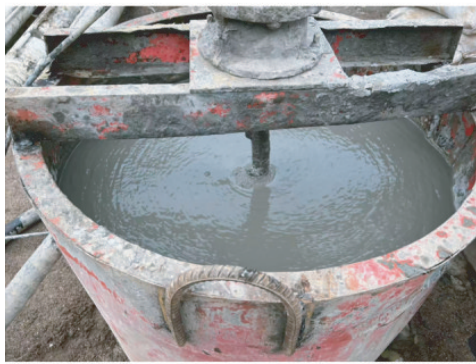
(c) 现场膏浆制备
