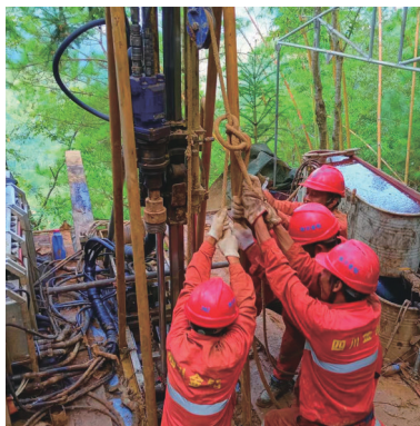
图5 内置式吊锤使用现场
