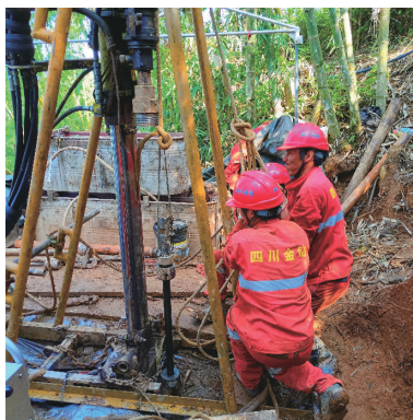
图6 内置式吊锤使用现场
