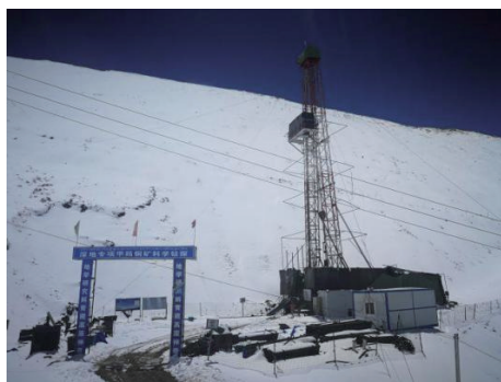
图 1 钻探现场全景
