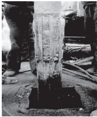
图2 止水伞现场实物
