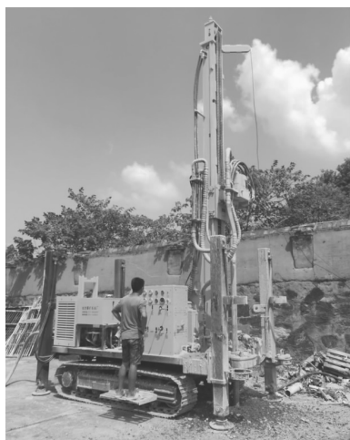
图7 长沙县地源热泵孔施工
