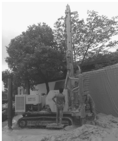
图 6 益阳市郊矿渣治理监测井施工
