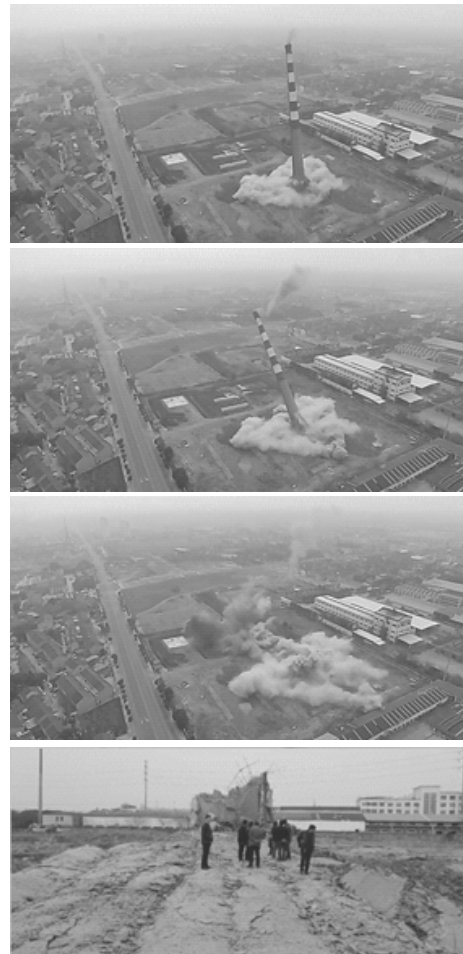
图 6 爆破倒塌瞬间及爆破效果图
