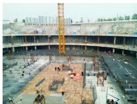
图 11 基坑开挖到底效果
