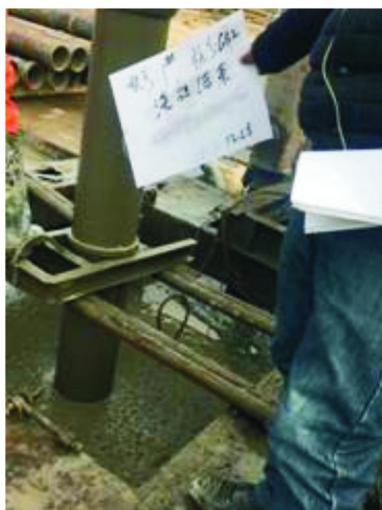
图1 试桩 GB2 刚浇注完毕效果
