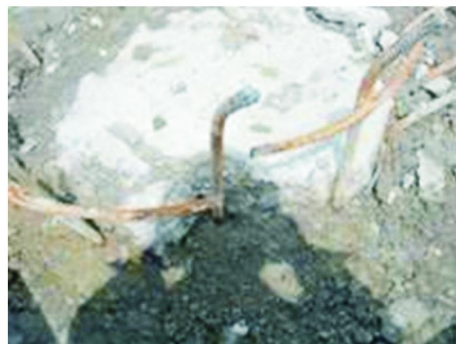
图5 钢筋周围泛砂现象
