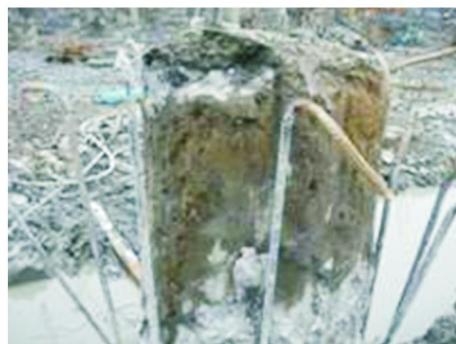
图4 桩侧泛砂现象
