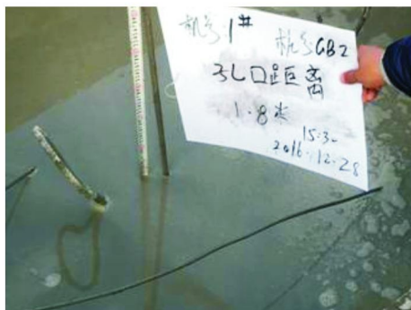
图2 试桩 GB2 浇注完 50 min 后效果
