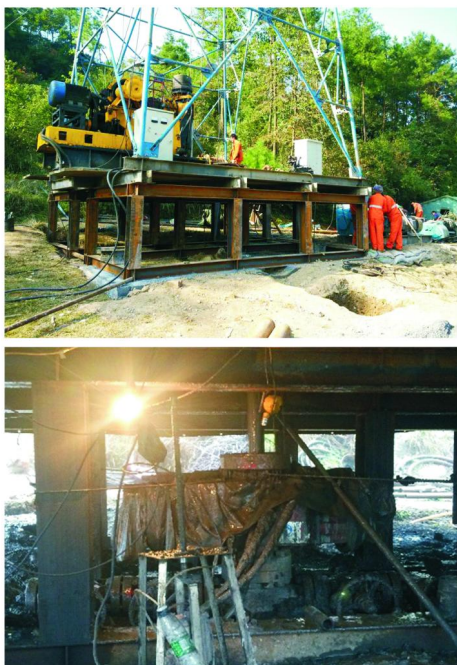
图1 华地一井的钻塔基座现场照片
