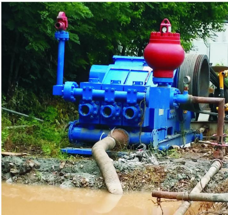
图7 3NB-500型钻井泵水力压裂
