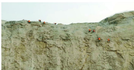
图2 主动防护网施工
