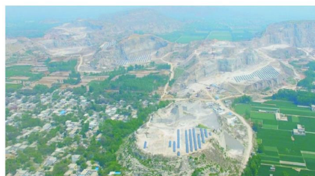
图6 爱康嘉祥 20 MW 山地光伏电站排险加固工程治理后项目全景
