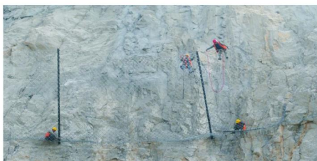
图3 被动防护网施工
