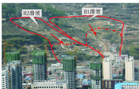
图 1 西山滑坡全貌
