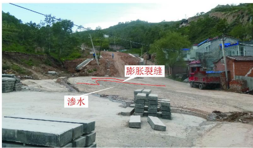
图10 H1 滑坡前缘轻微鼓胀及渗水
