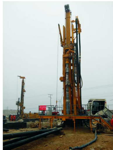
图5 三开钻进钻具现场连接图
