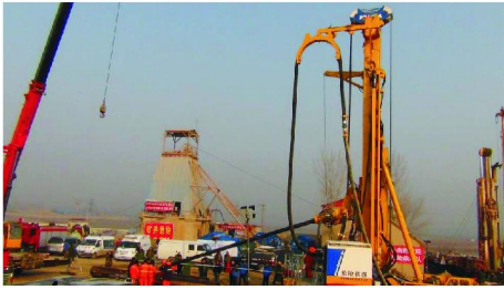
图6 空气反循环钻进施工
