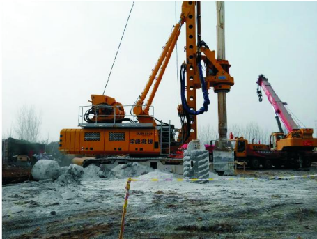
图3 旋挖钻机施工
