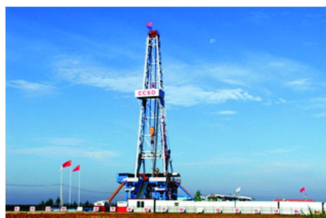
图1 中国大陆科学钻探工程施工现场
