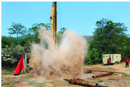
图4 万山缺水山区空气潜孔锤技术应用
