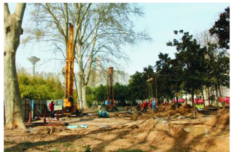
图5 河南黄河迎宾馆浅层地热能地埋管钻探现场
