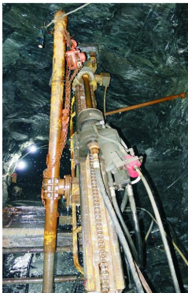
图1 Z7559型全液压钻机施工现场
