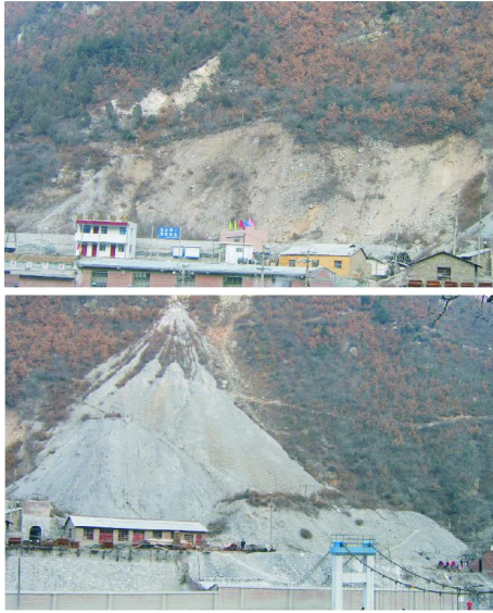
图 1 小厂坝铅锌矿矿山边坡治理前现状
