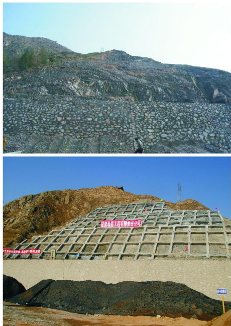
图7 兰州市北环路安宁段高边坡工程治理前后实景
