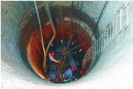
图4 集水管施工机械在主井内的施工情况
