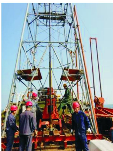
图3 施工现场照片
