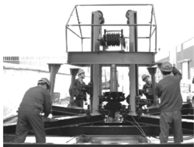
图3 安装顶主腿
