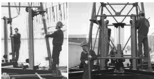
图5 安装连接杆
