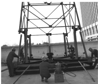
图4 顶升塔架后对接主腿
