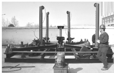
图1 安装底盘和地面安拆装置
