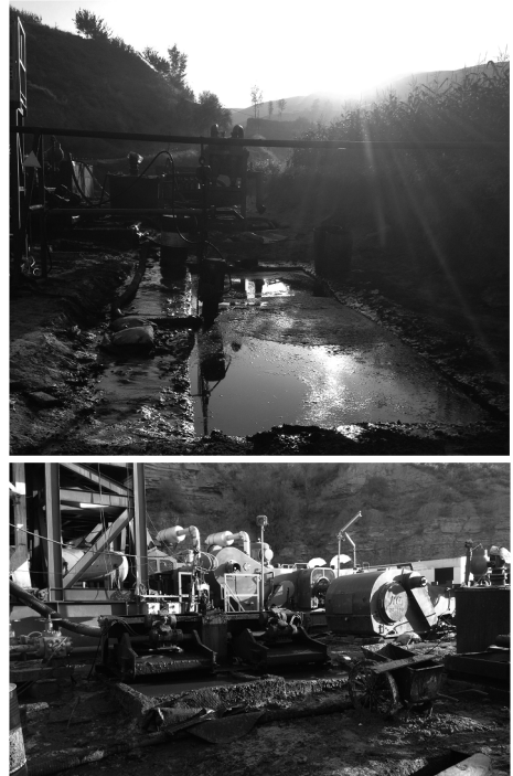
图3 刚开始现场泥浆沉砂系统
