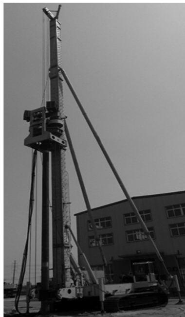
图3 ZLG22米折塔履带式螺杆桩机施工现场
