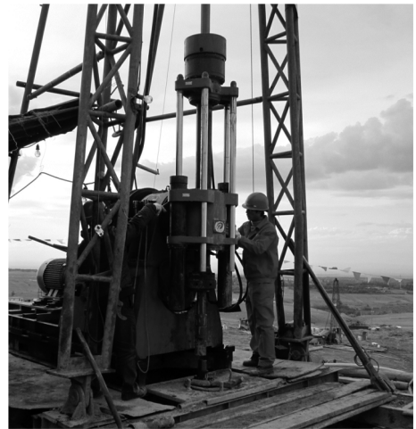
图4 总体外观照片
