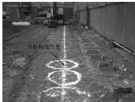
图5 排桩施工场地处理后的照片
