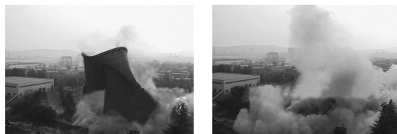
图6 爆破倒塌过程
