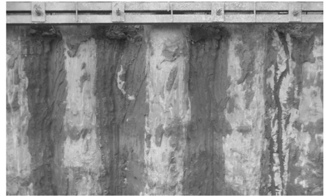
图6 开挖后局部桩间情况
