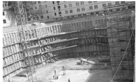
图7 开挖到底后情况
