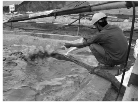
图 2 在喷射的水流上加入泥浆材料
