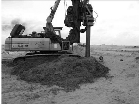
图 1 旋挖钻机挖出的砂,现场干净整洁
