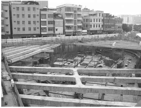
图5 基坑开挖后南侧天然地基民宅实景
