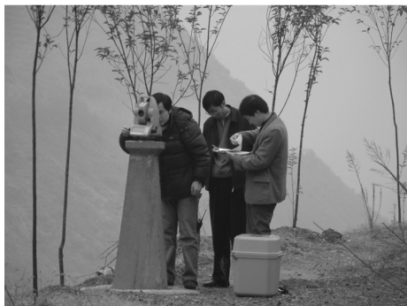
图 1 全站仪在高切坡监测中的应用
