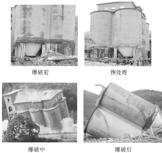
图 2 双排水泥窑爆破过程
