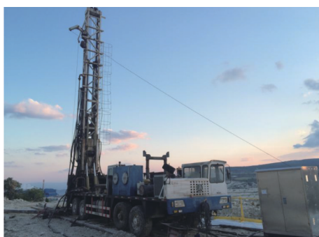
图1 SDC-1500型钻机在土耳其施工对接井
