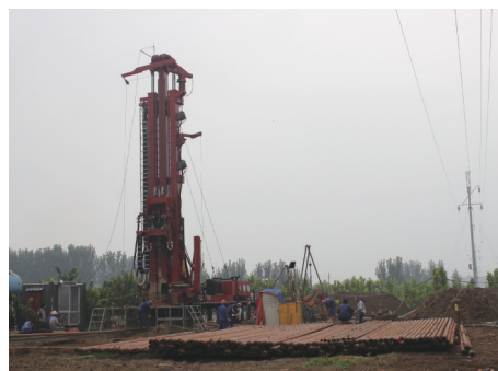
图3 SDC-2500型钻机在永清施工地热井
