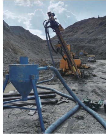
图2 空气反循环施工现场
