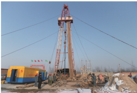
图1 地热井气举反循环施工现场
