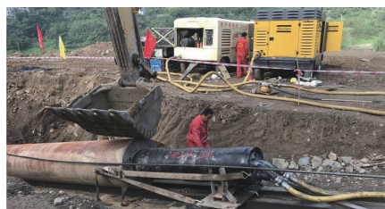
图1 夯管锤助力施工
