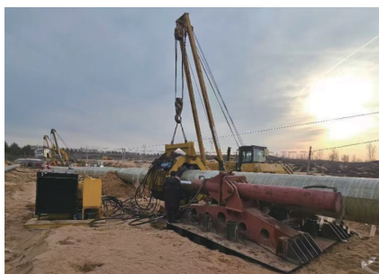
图11 推管机榆林穿越工程施工现场
