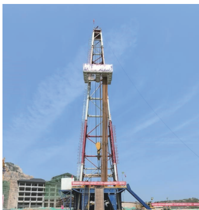
图3 石家庄鹿泉LQDR-1地热温泉井施工现场
