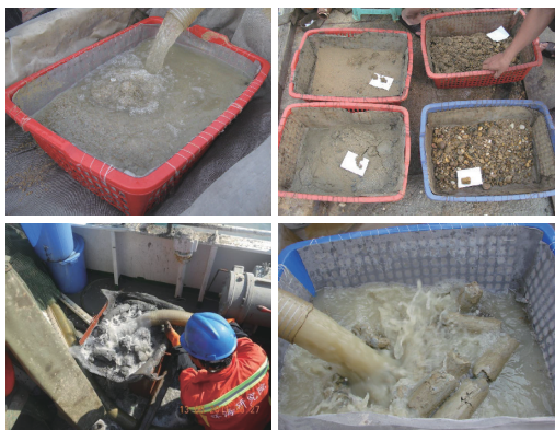
图3 水力RC钻探技术在海域进行海洋地质调查钻探取心(样)施工场景
