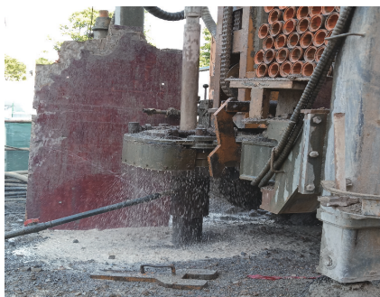
图4 潜孔锤钻进注水除尘
