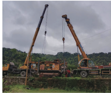
图2 吊车吊移钻机
