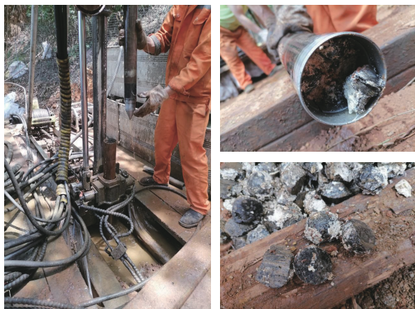
图6 钻孔堵漏小球现场应用测评
