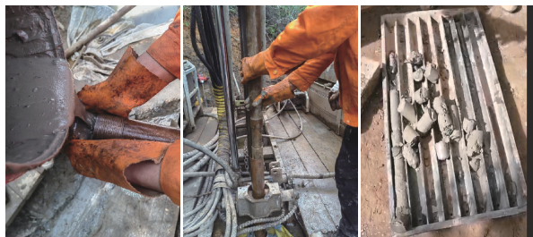
图9 内管投放抗分散速凝水泥工艺堵漏及形成的固结体
