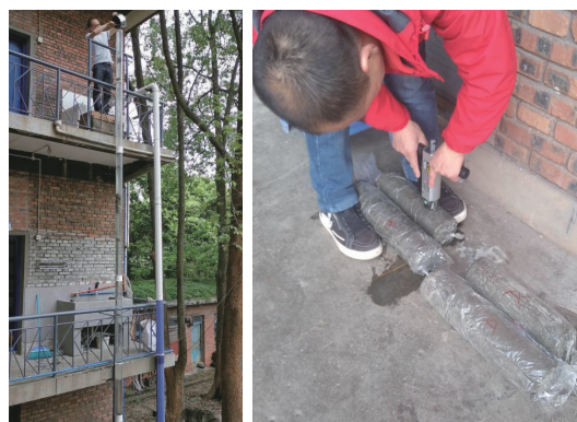
图8 有水管道的抗分散和凝固强度测试
