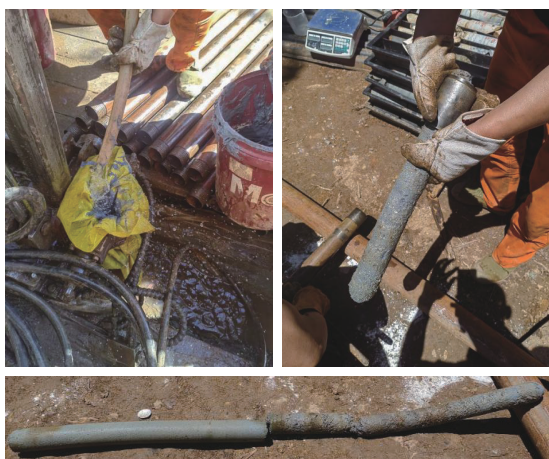
图11 孔口投放疏水化学胶凝材料堵漏及形成的固结体
