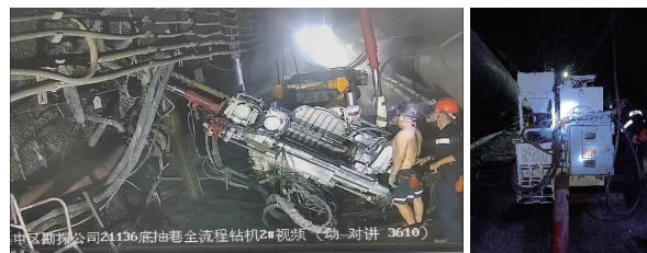
图6 井下钻场施工照片
