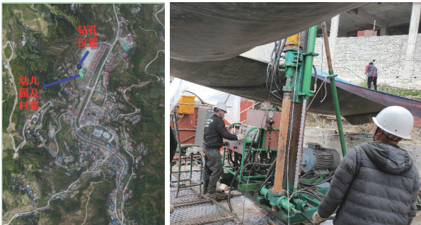
图8 电驱动便携式钻机在福泉市谷龙磷矿勘探的应用
