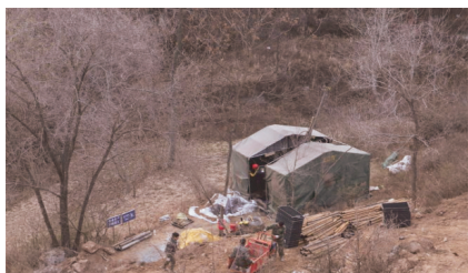
图1 甘肃便携式钻机施工
