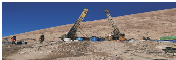
图2 双机同时施工
