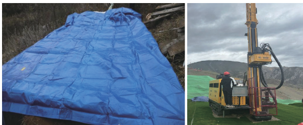
(a) 铺设防渗布 (b) 地面硬化
